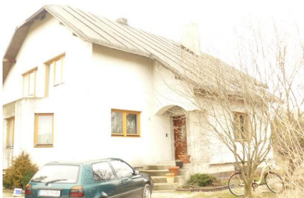
Zdjęcie. Widok budynku.
