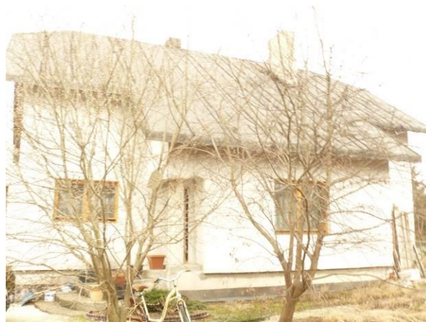
Zdjęcie. Widok budynku.
