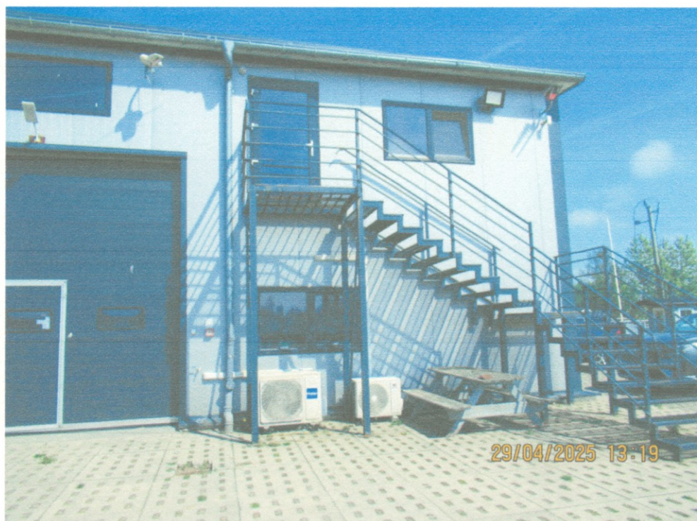
Budynek produkcyjny z częścią biurowo – socjalną
