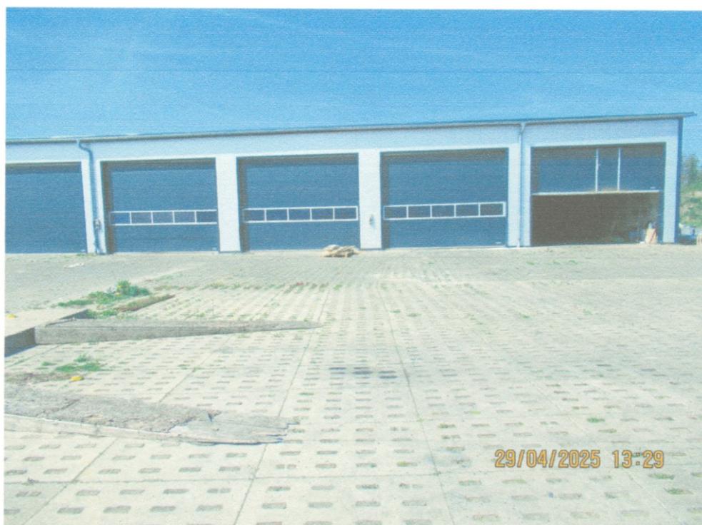
Hala produkcyjno - magazynowa
