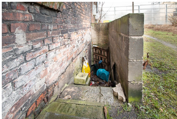
Wejście do piwnicy z zewnątrz budynku
