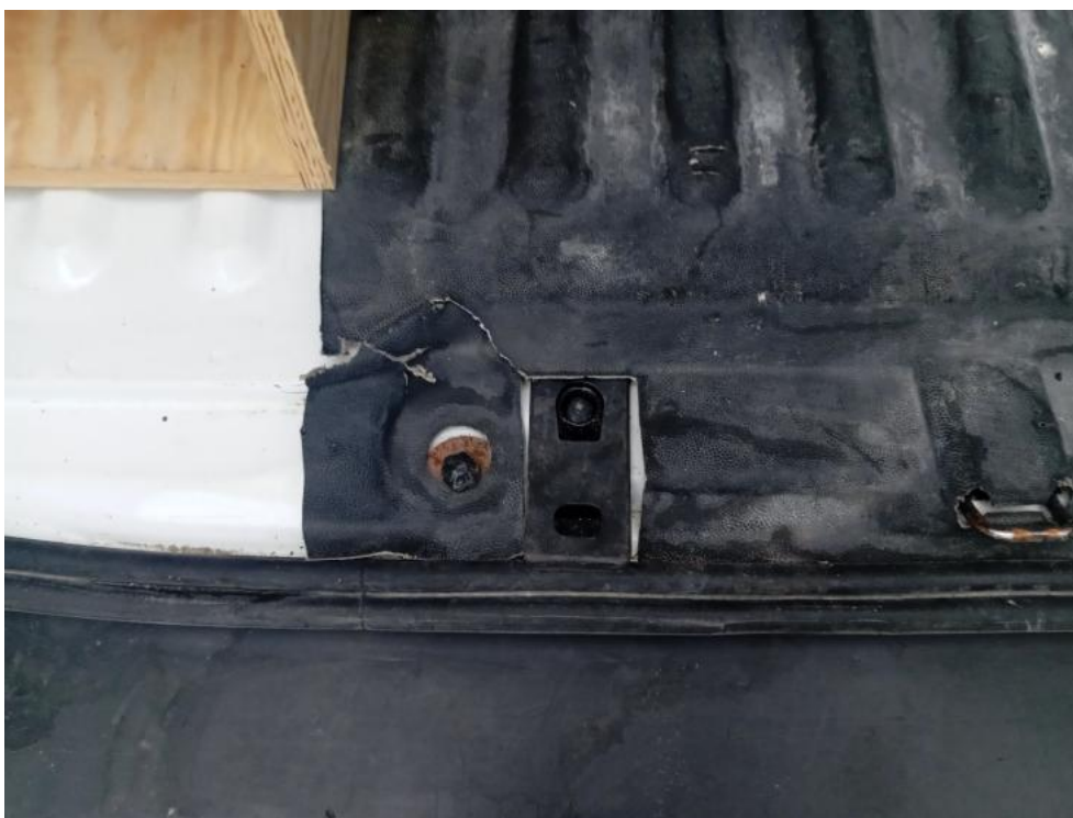
Fot. 113. - zdjęcie pogłądowe 2
